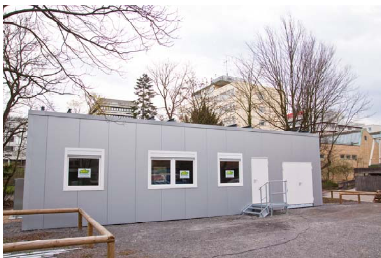
Im Bau: Das „Smart Home“ auf dem Gelände des KIT. (Foto: Gabi Zachmann)
