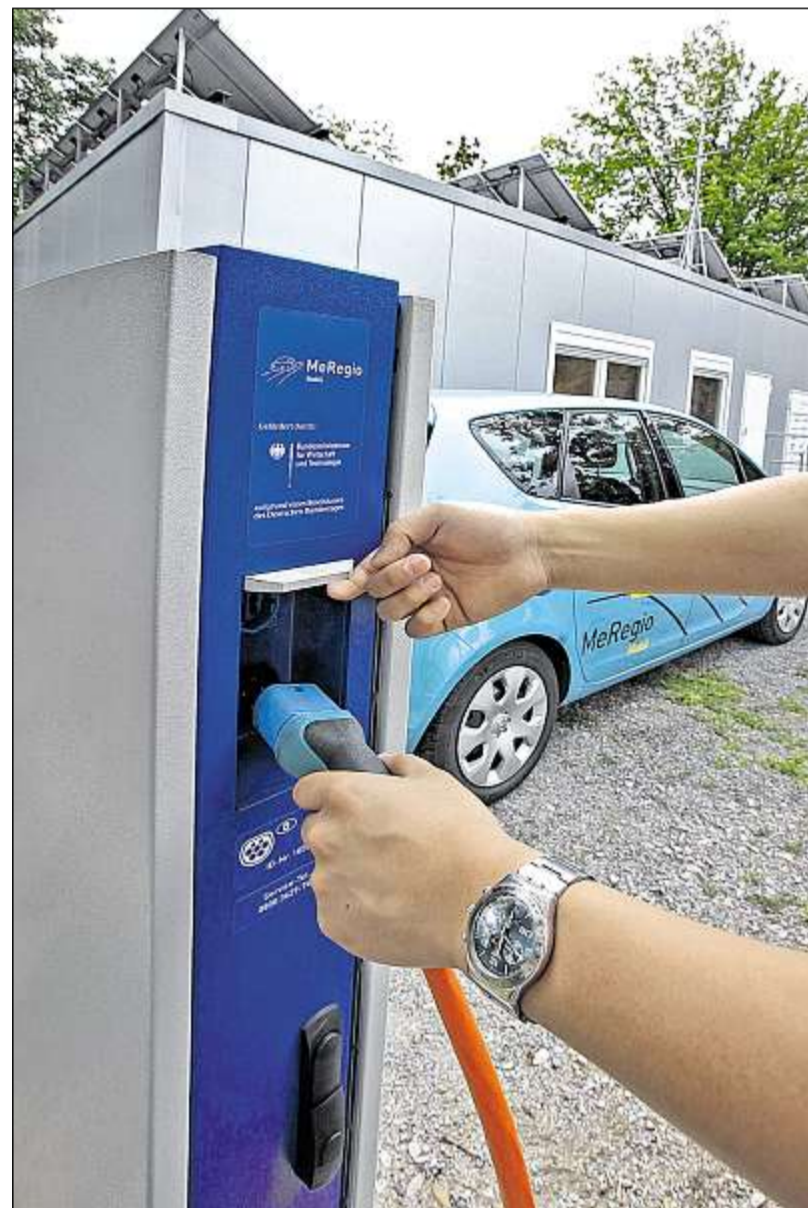
EINGEBUNDEN in das Energiemanagement des Smart Home ist auch ein Elektrofahrzeug, ein Prototyp von Opel.
